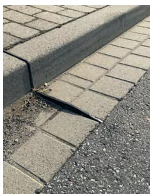
Schäden an Bewegungsfugen aus Kautschuk (NBR)
