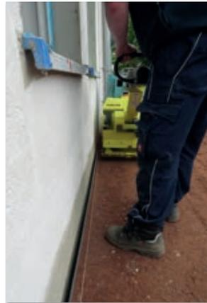
Die bauliche Trennung zum Gebäude sollte sich dabei nicht nur auf die Deckschichten (Pflaster- oder Plattenbeläge) beziehen, sondern den gesamten Baukörper, also auch die Frost- und Trag-schichten einbeziehen. Durch überstehenden Einbau der Schutzlage werden Beschädigungen und Verschmutzungen während der Bauphase verhindert. Nach Abschluss
