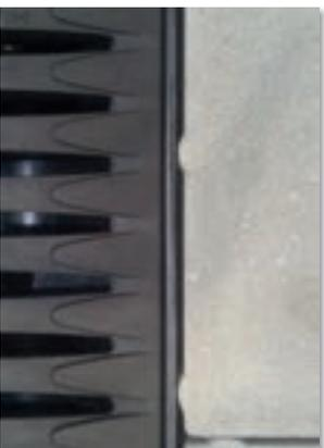
Eine besondere punktuelle Bruchgefahr für die Entwässerungsrinne besteht, wenn angrenzende Pflastersteine mit z.B. vorgeformten Abstandhaltern oder unregelmäßiges Natursteinpflaster knirsch eingebaut werden.
